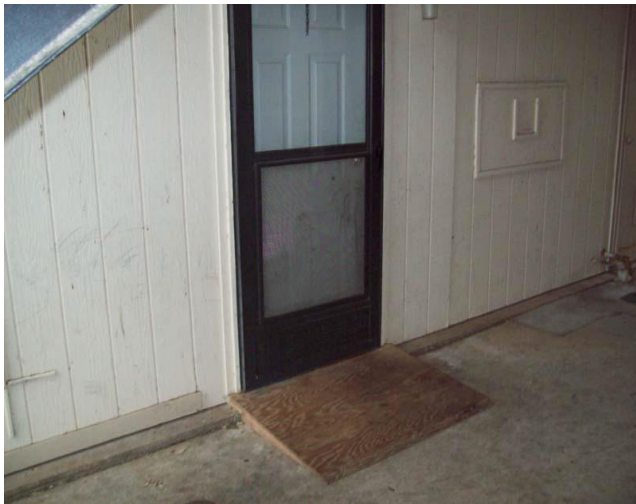
43. Non compliant wooden ramp
