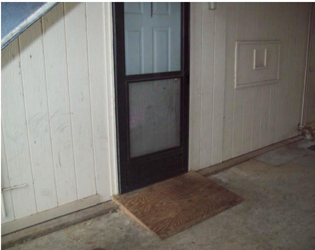
43. Non compliant wooden ramp
